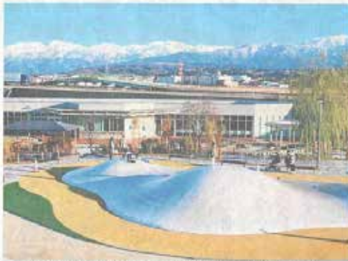
子ども向けの設備が豊富で眺めも良い道の駅「KOKOKURUBE」 —黒部市堀切
